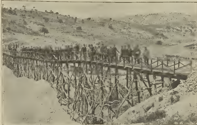
FÁBRICA DE CEMENTO PORTLAND Y CAL HIDRÁULICA DE BUTSENS Y FRADERA Puente provisional para la conducción de los materiales desde las canteras á los hornos
